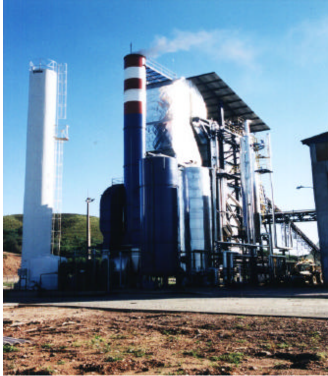
Centrale alimentée à la biomasse
